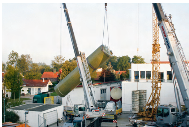
Frühmorgens wurde der erste Tank eingehoben
