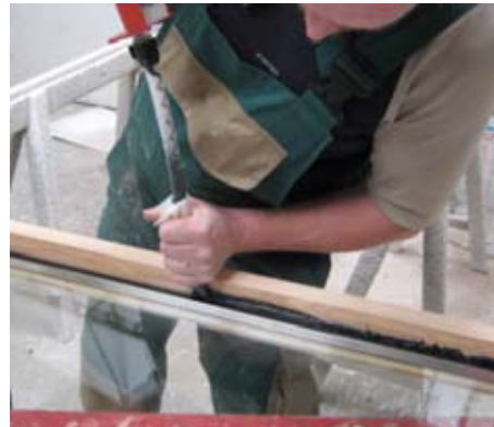
Kleben im Falzgrund zwischen Isolierglasscheibe und Fensterrahmen mit OTTOCOLL® S81
