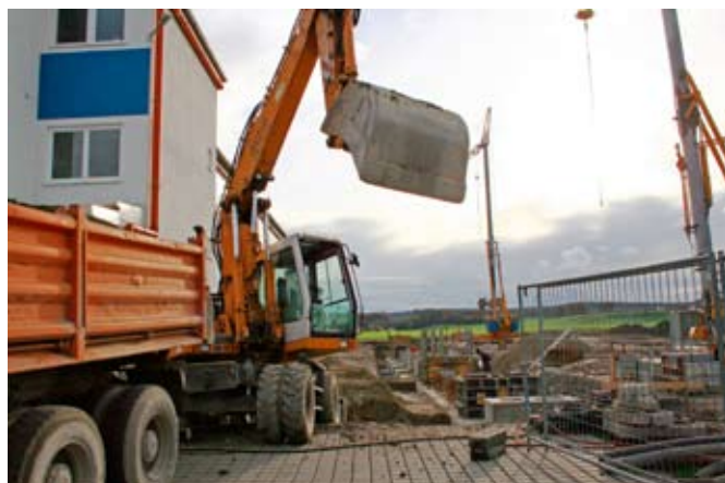
Baubeginn Anbau Strohhof
