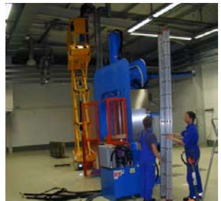
Bild 5, Installation der Presse
