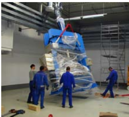
Bild 3, Aufrichten der Presse (innen)
