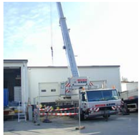
Bild 4, Aufrichten der Presse (außen)
