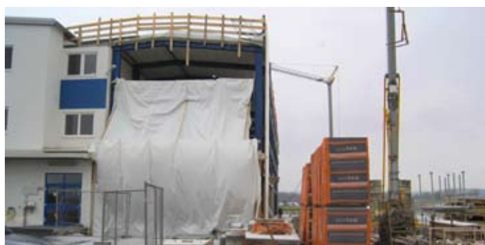
Erweiterung des Versandlagers im Strohhof
