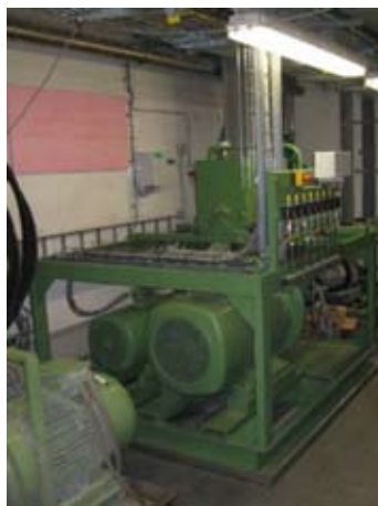
Das Hydraulikaggregat für den neuen Mixer mit 2 Elektromotoren mit der Leistung von 132 KW für die Mischwerkzeuge und 45 KW für den Planeten und Anker (Gewicht ohne Öl 2,2to).
