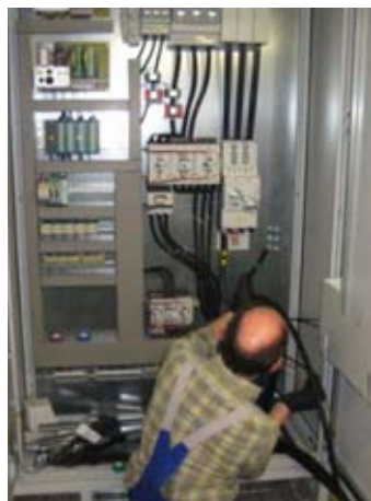
Die Steuer und Leistungsschränke für die werden installiert und für den Betrieb des neuen Mixers vorbereitet.
