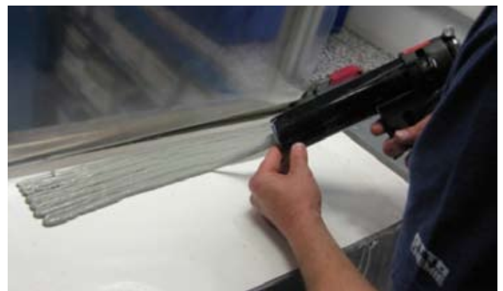
Laufende Qualitätskontrollen während der Inbetriebnahme – Volumen- und Gewichtskontrolle, Kolbensitz, Kontrolle bezüglich Lufteinschlüssen, ... – wie im Bild zu sehen.
