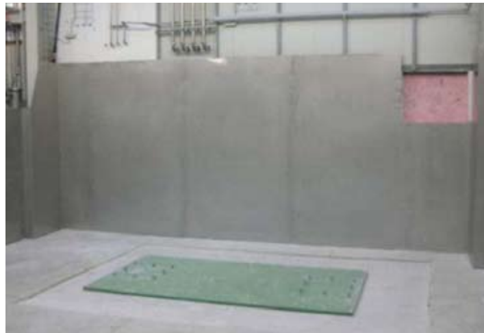
Die Vorbereitung des Standplatzes M7 – das Fundament wurde vom Hallenboden Halle 1 entkoppelt und stellt die Grundlage des 7to Mixers dar.
