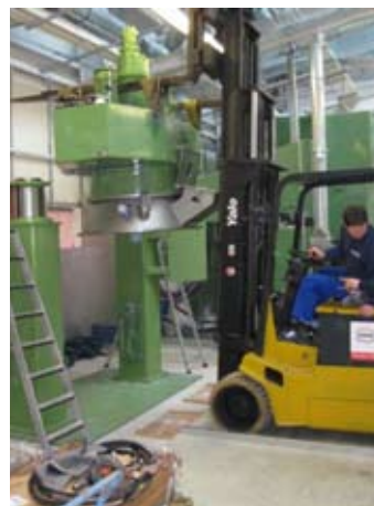
Der Maschinenkopf wird mit viel Feingefühl über den Hebeelementen positioniert und montiert.
