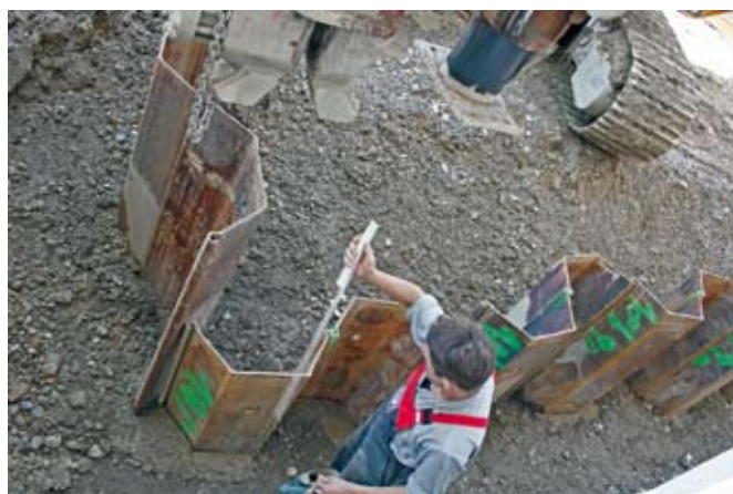
Spundung der Baugrube
