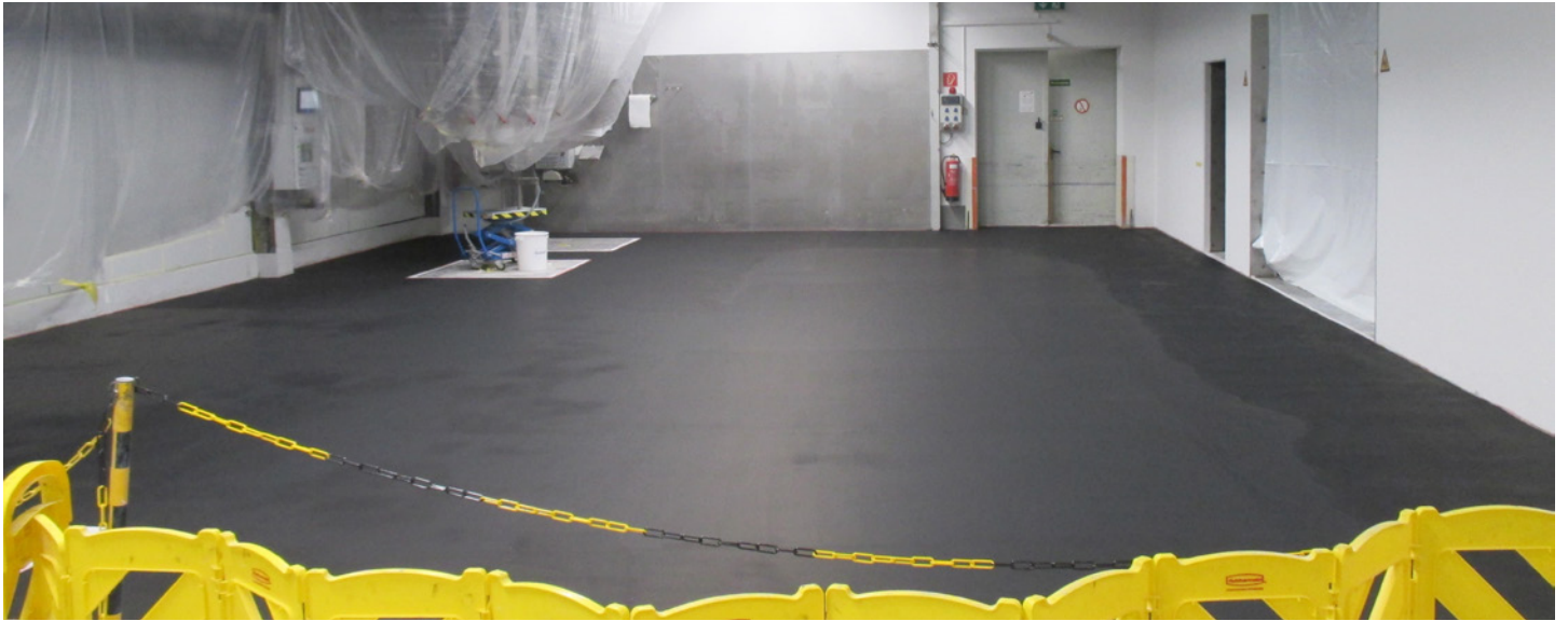
Bild 2: Bodenerneuerung im Bereich der Bodenwaagen
