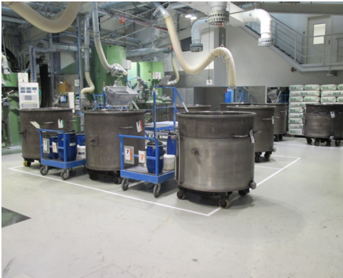
Bild 3: Stellfläche für vorbereitete Kessel vor den Mixern 5 bis 7
