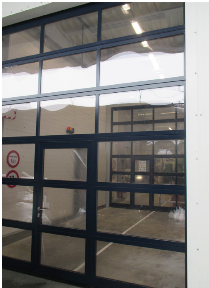
Bild 1: Doppeltorschleuse am Eingang Halle 2 (Mischbereich)
