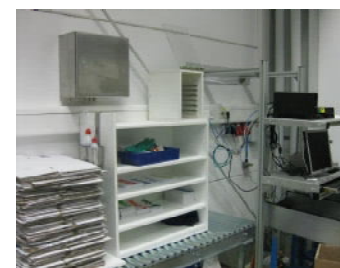
Installation Daten und EDV-Systeme
