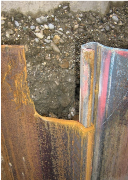
Bild 2 Spundwandabsplitterung
