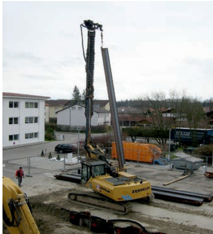
Bild 1 Spundarbeiten
