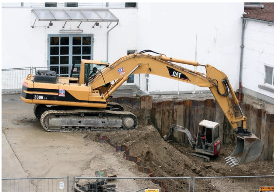
Bild 4 Teamarbeit beim Aushub
